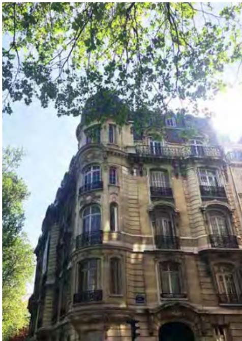
L'hôtel particulier du 8 e arrondissement qui accueillera Paris Internationale. Photo : D.R.
